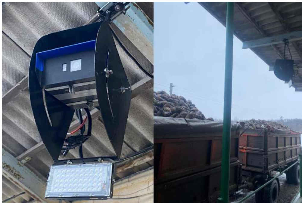
Рисунок 5 – Защитный корпус системы технического зрения на приёмном пункте сахарного завода
