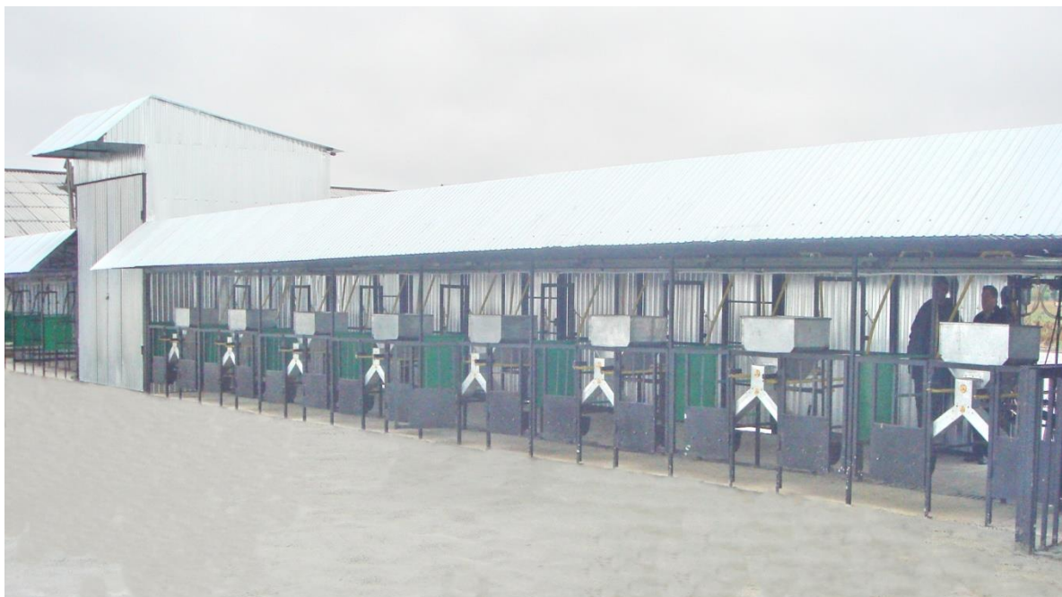
Летняя доильная площадка на 24 скотоместа
