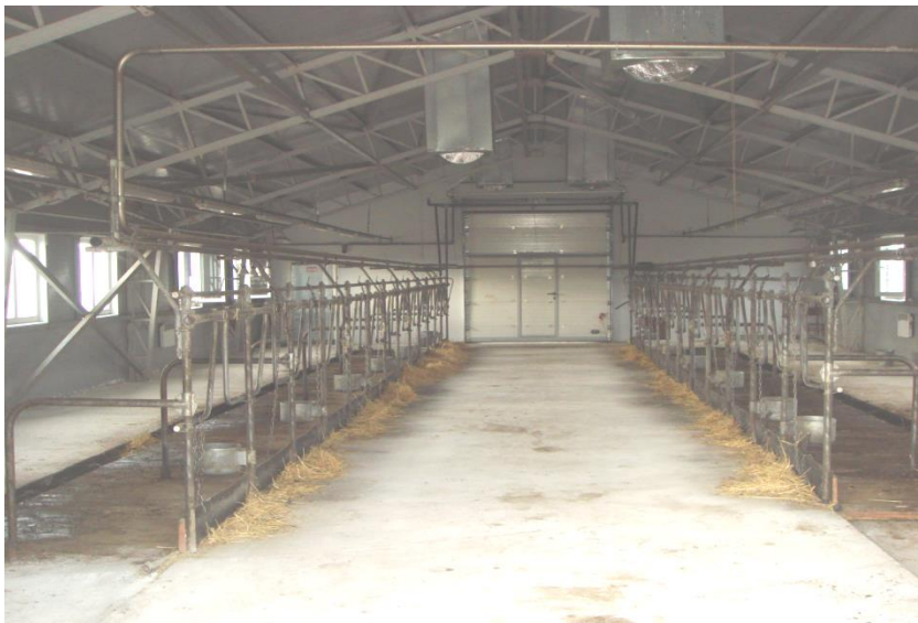
Общий вид оборудования коровника
